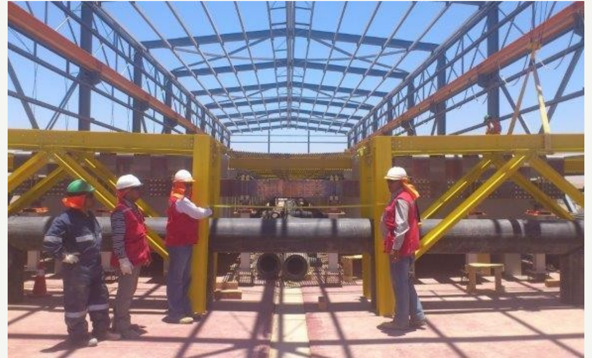
Montaje de estructuras
